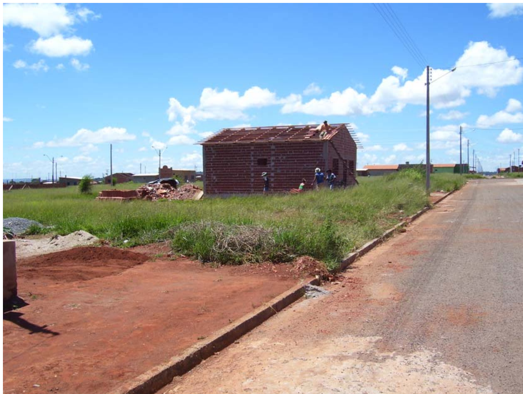
Figura 3 - Autoconstrução, Residencial Triunfo
