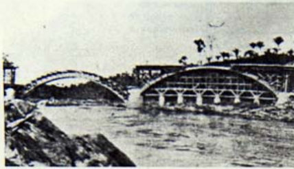
Fig. 26 Vista geral do cimbração pronto. O arco Patrocínio sem apoios no fundo do rio é uma treliça de concreto. O arco Ouvidor se apóia em tubulões rasos de concreto. [33]
