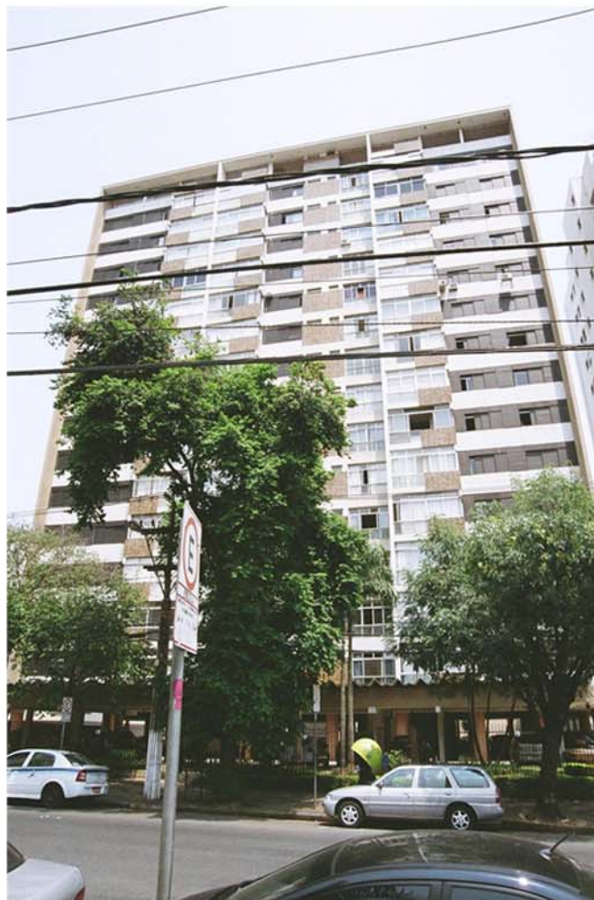
Fig. 56 - Fachada atual do Edifício Piauí-Maranhão. Janelas de alumínio anodizado na cor bronze, substituem as janelas originais de PVC, azul claro, que permanecem na fachada posterior. Fonte: Foto do autor. 2007.
