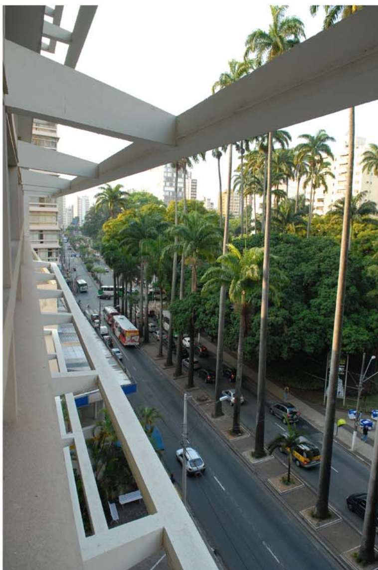
Fig. 127 - Foto obtida da janela do 5º andar de onde se observa a Rua Irmã Serafina, e Avenida Anchieta em seguida. Observar apoios dos brises que hoje estão sendo substituídos. Fonte: Foto do autor - 2008.
