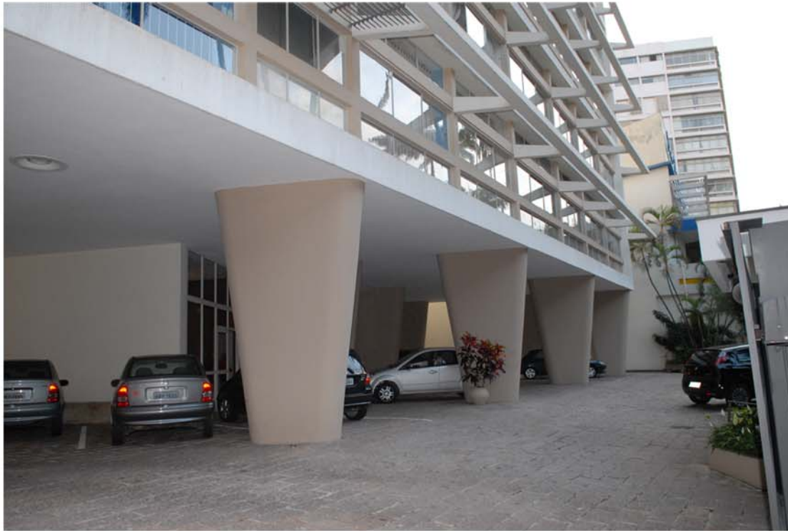
Fig. 124- Pilares em "V" do térreo, hoje ocupados por automóveis. Observar laje caixão perdido que se repete nos andares tipo. Ao fundo o Edifício Roque de Marco do arquiteto Charles Victor, com fachada semelhante à do Itatiaia. Fonte: Foto do autor - 2008.
