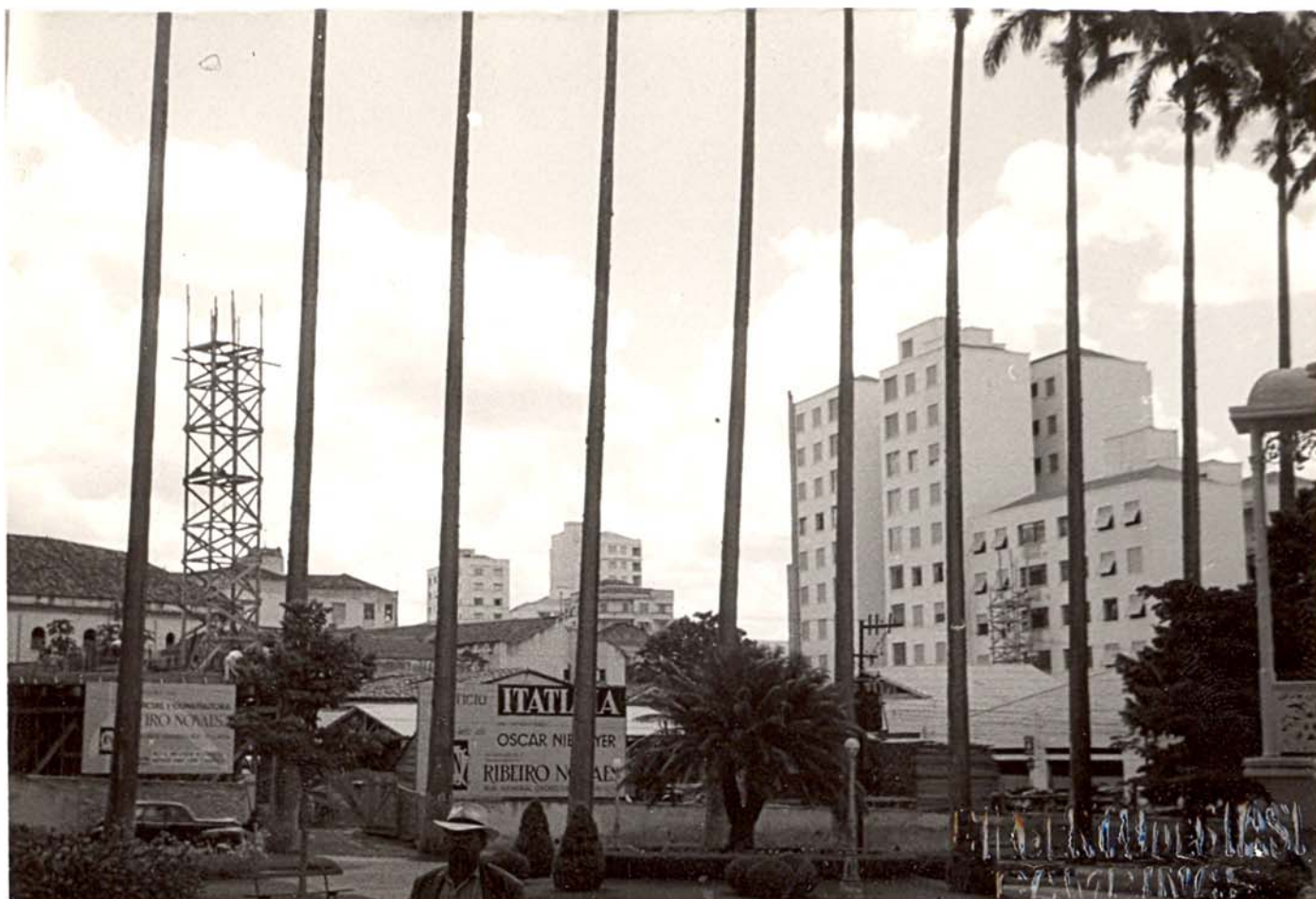
Fig. 117 - Início das obras do Itatiaia pela Comercial e Construtora Ribeiro Novaes. Irmã Serafina, ainda com pista única, sua duplicação se dá em 1959. Fonte: Coleção GB 0201 - Acervo Museu da Imagem e do Som de Campinas.
