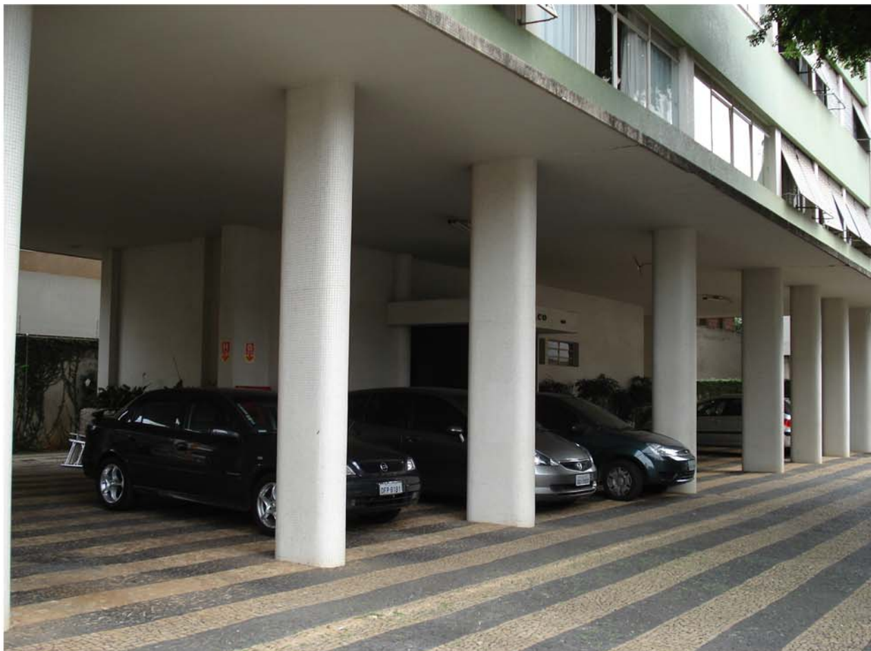
Fig. 77 - Térreo do Acapulco com os pilares de extremidades arredondadas. Fonte: Foto do autor.
