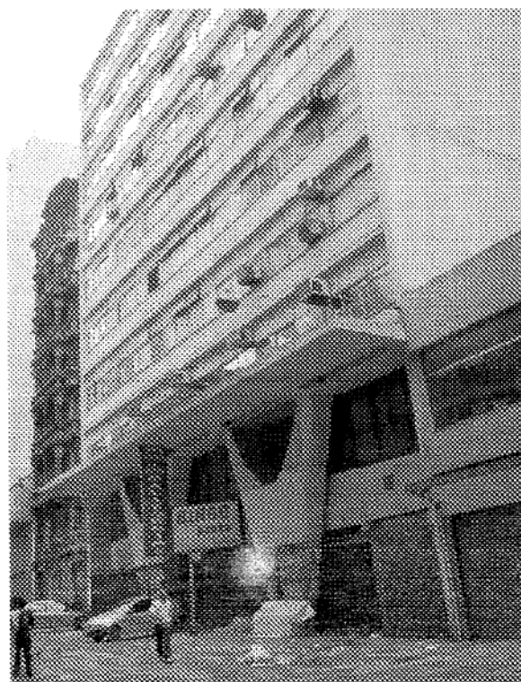
Fig. 88 – Edifício Califórnia (construído) e com os três novos pilares. São Paulo. Observar marquise sobre pilares - recurso utilizado no Edifício Acapulco. Fonte: Leal, 2003: 92a
