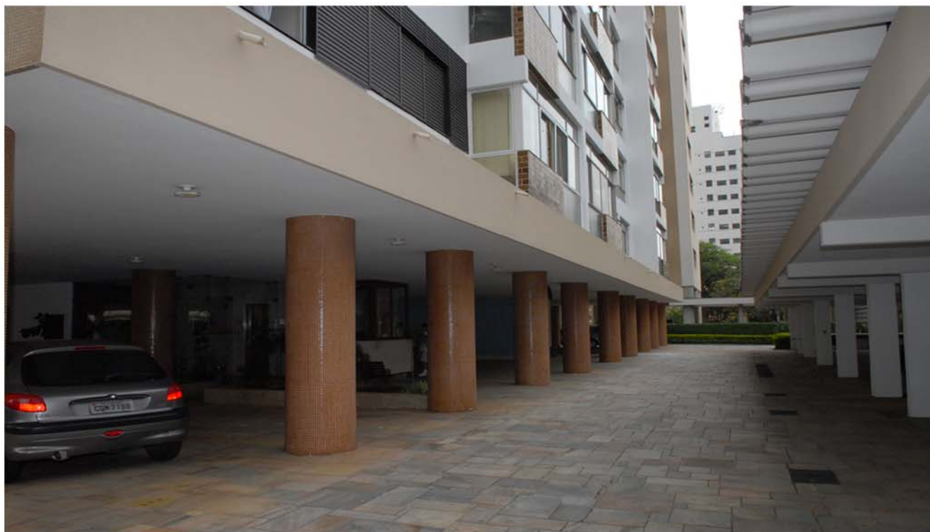
Fig. 57 - Recuo frontal do Piauí-Maranhão, mostrando à direita cobertura (fibro cimento) para automóveis, substituindo a área originalmente destinada a jardim e espelho d'água, ver figura 49. Fonte: Foto do autor. 2007.
