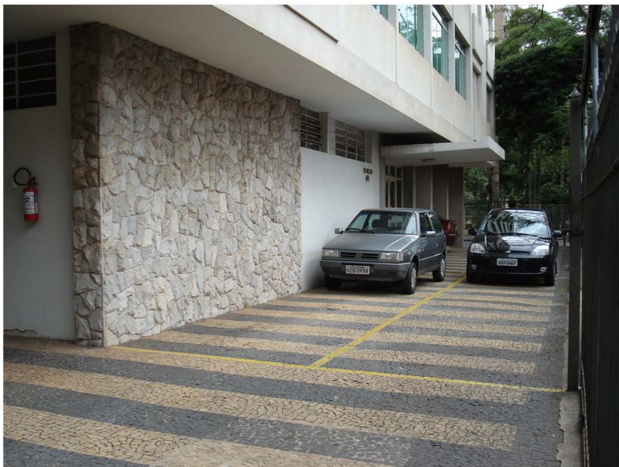
Fig. 68 - Edifício Veneza e as vagas para automóvel sobre o recuo frontal. Fonte: Foto do autor.
