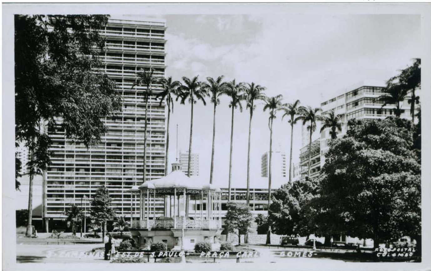
Fig. 120 - O Itatiaia concluído, ao lado do Clube Semanal de Cultura Artística (em obras) e do Edifício Roque de Marco, ambos de autoria do arquiteto Charles Victor (autor do 1º estudo para o Edifício Itatiaia) - início da década de 1960. Fonte: Coleção BMC 147 - Acervo Museu da Imagem e do Som de Campinas.
