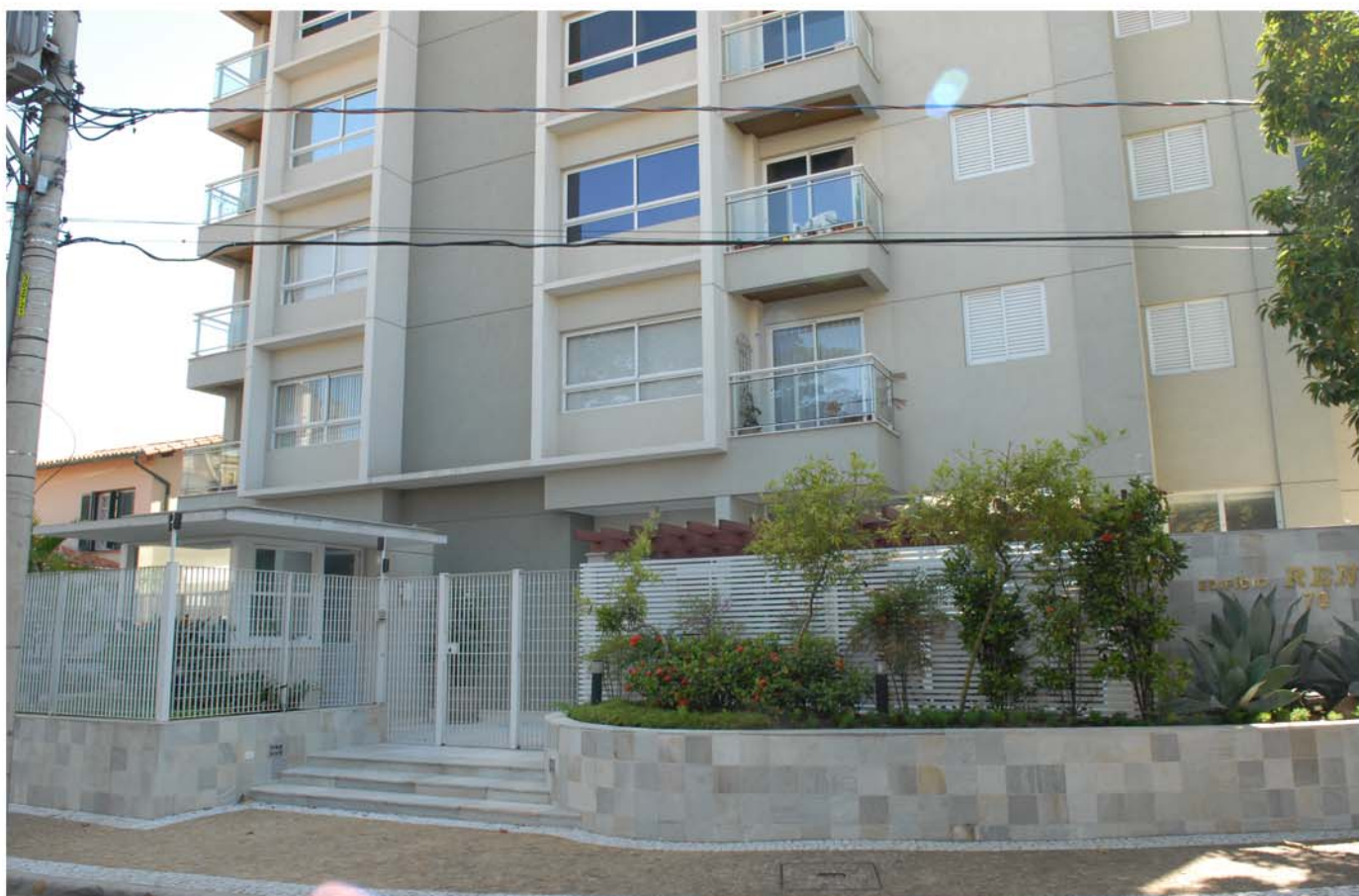
Fig. 31 - Edifício Rennes - Térreo elevado e guarita no recuo. Fonte: Foto do autor - 2008.
