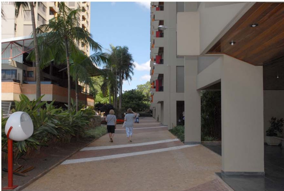
Fig. 36 - Residencial Cidades do México. Rua interna. Fonte: Foto do autor - 2008.
