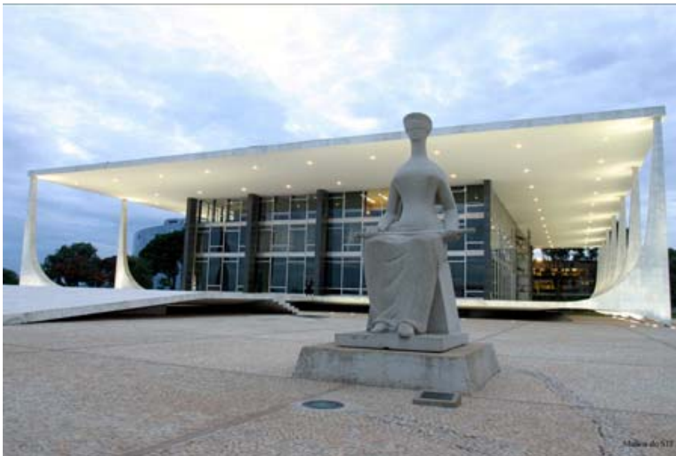
Fig. 85 – Supremo Tribunal Federal – Brasília, projeto Oscar Niemeyer - cálculo estrutural Werner Müller. Fonte: www.imagens.google.com.br
