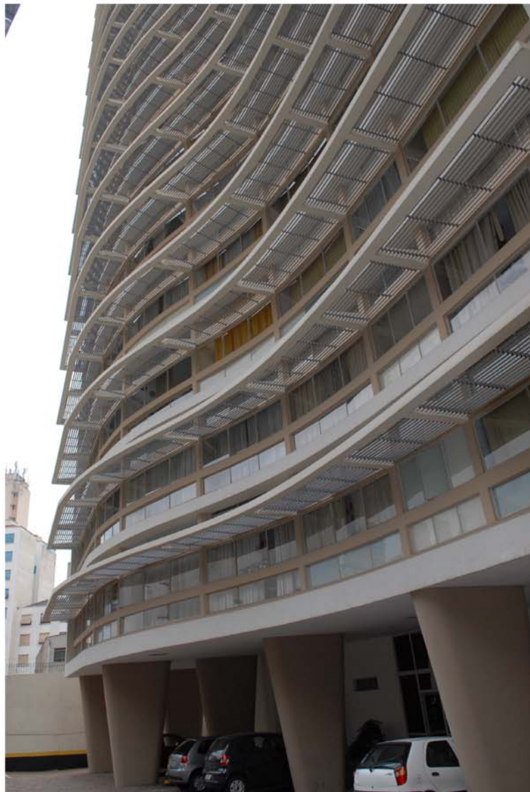
Fig. 125 - Fachada do Itatiaia para a Rua Irmã Serafina. Fonte: Foto do autor - 2008.
