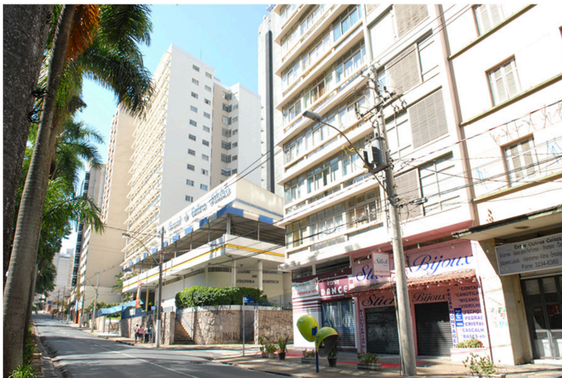
Fig. 24 - Fachada do Edifício Roque de Marco, voltada para Avenida Anchieta. No centro o Clube Semanal de Cultura Artística e ao fundo o Edifício Itatiaia. Fonte: Foto do autor.
