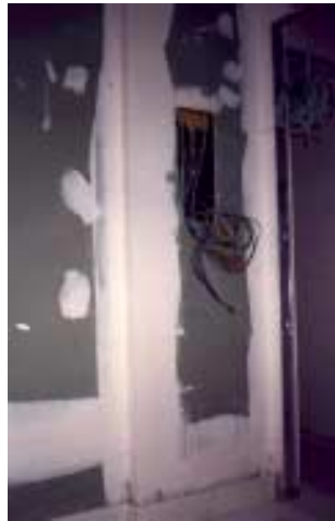
FIGURA 4.6 – Instalações embutidas nas divisórias de gesso acartonado
