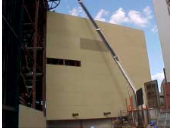
FIGURA 3.3 – Colocação de painéis pré-moldados de concreto em fachada
