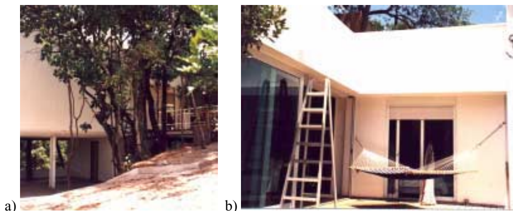
FIGURA 4.34 – Vista residência João Grillo
