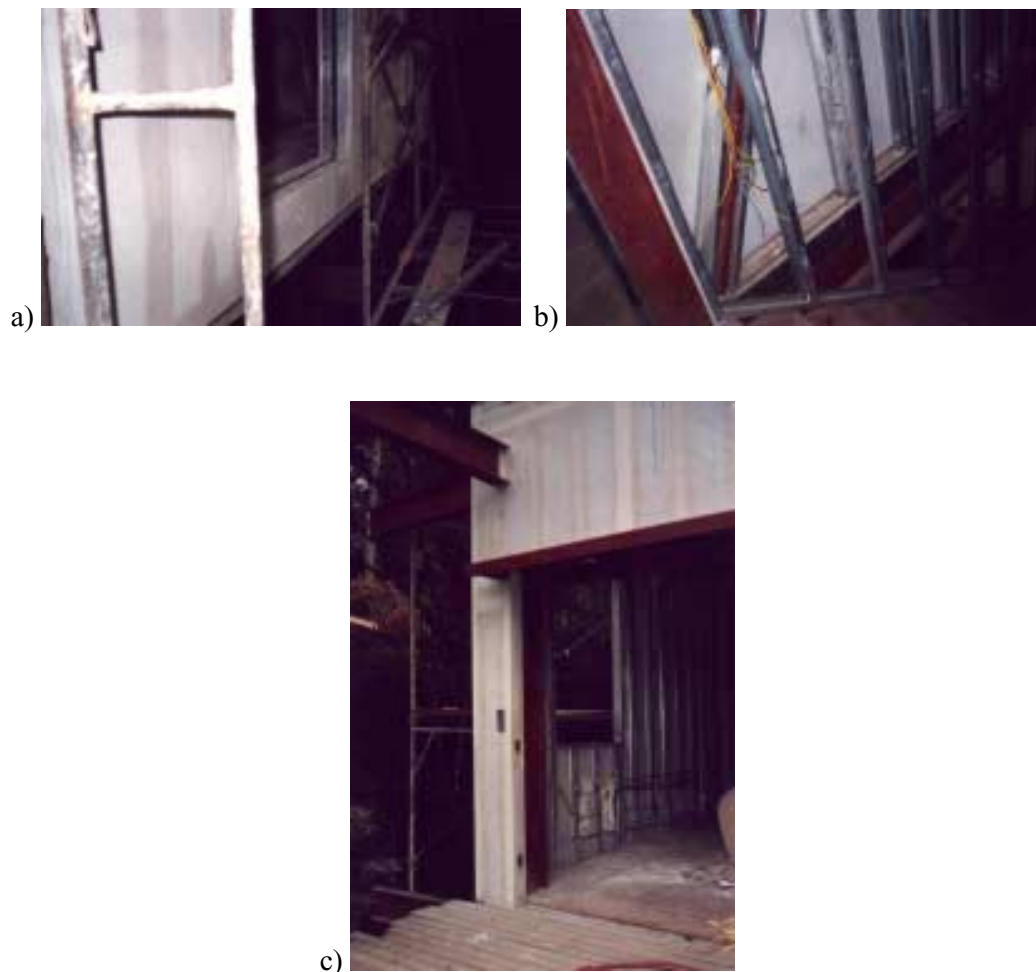
FIGURA 4.37 – Fixação dos painéis de vedação externos
