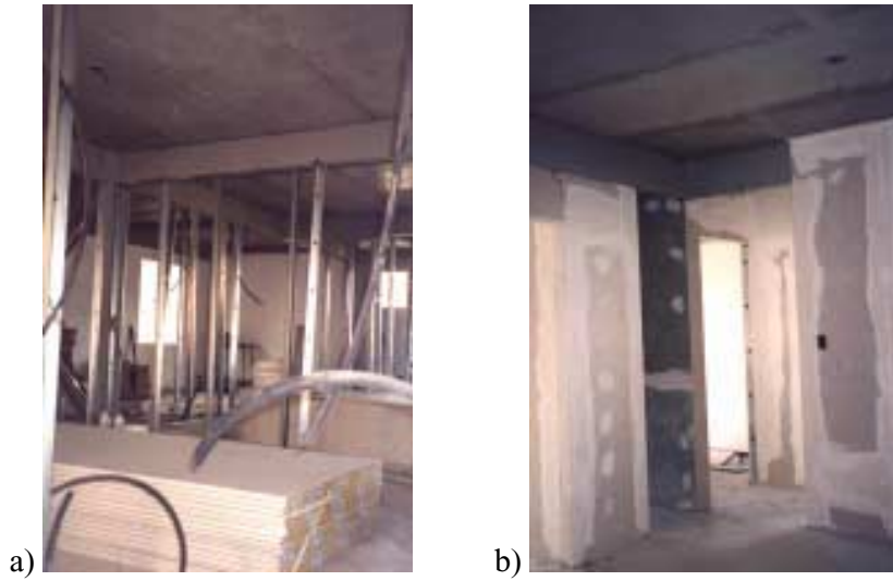
FIGURA 4.19 – Divisórias internas montadas
