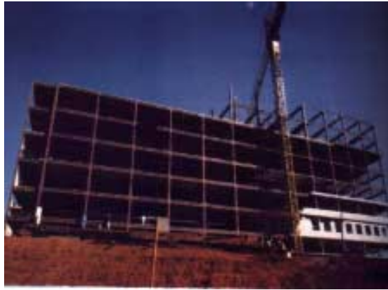
FIGURA 4.30 – Fases da obra sendo executadas simultaneamente
