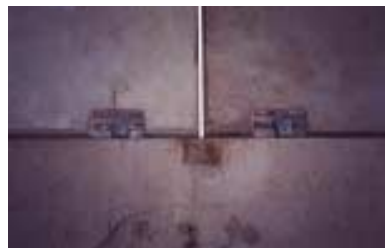
FIGURA 4.62 – Painéis verticais se apóiam nos horizontais
