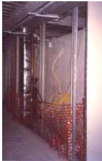
FIGURA 4.57 – “Shafts” previstos para manutenção
