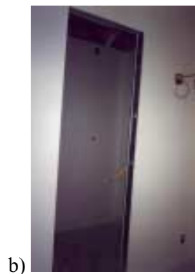
FIGURA 4.7 – Divisórias de gesso acartonado montadas
