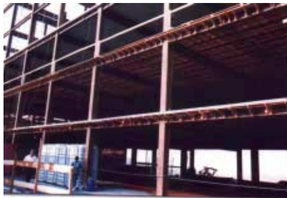
FIGURA 4.31 – Esquema de execução das lajes
