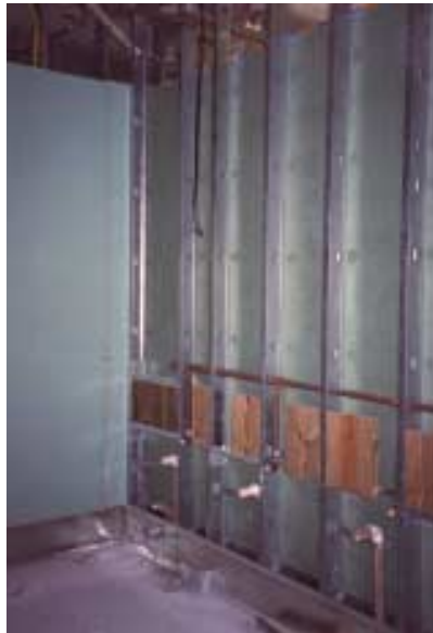
FIGURA 3.1 – Montagem do sistema de fechamento vertical em gesso acartonado
