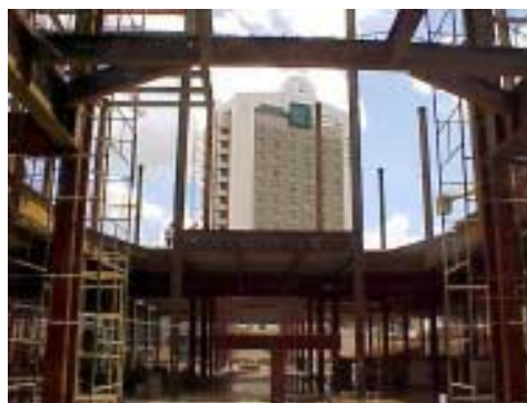
FIGURA 4.48 – Obra em andamento e vista do Hotel existente FONTE – foto cedida pela ARCOM, 2000
