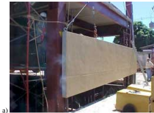
FIGURA 4.45 – Montagem dos painéis externos
