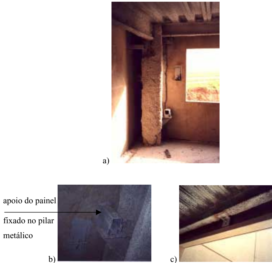
FIGURA 4.55 – Fixação painel externo/proteção passiva da estrutura metálica
