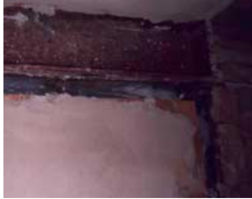
FIGURA 4.3 – Ligação alvenaria estrutura com cantoneira metálica
