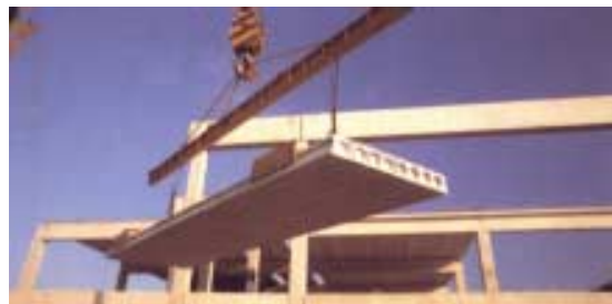
FIGURA 3.9 – Montagem de lajes em painéis de concreto extrudado alveolares FONTE – PREMO, 1999
