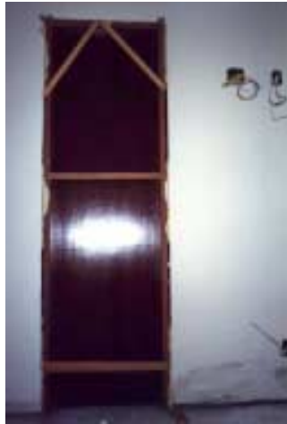
FIGURA 4.8 – Montagem – esquadria industrializada em divisória interna
