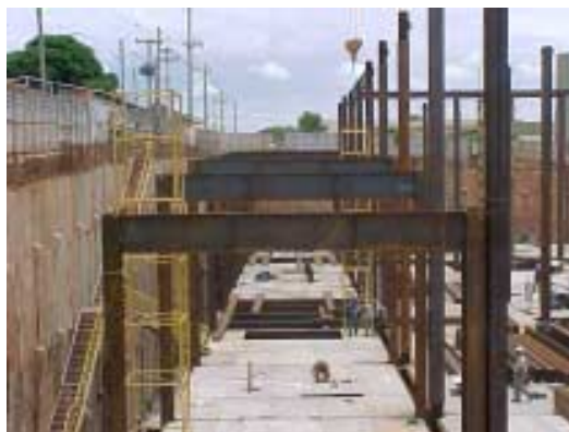
FIGURA 4.43 – Vigas para reconstrução de arruamento e paredes diafragma
