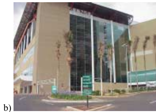
FIGURA 4.42 – Vista externa do edifício
