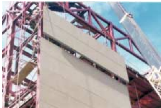
FIGURA 3.5 – PAINEL PRÉ-MOLDADO DE CONCRETO COM ALMA EM POLIESTIRENO
