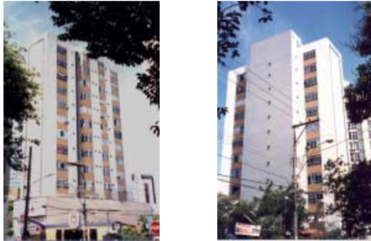
FIGURA 4.25 – Vistas Edifício Ary Scott
