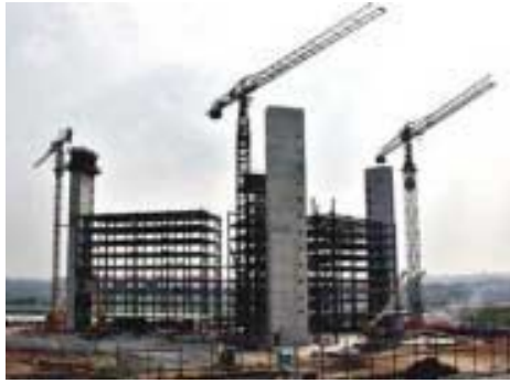
FIGURA 4.50 – Torres de concreto / início da montagem da estrutura metálica
