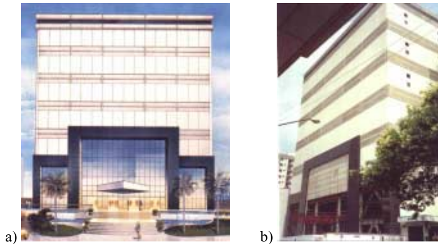
FIGURA 4.58 – Edifício Frei Caneca & Convention Center
