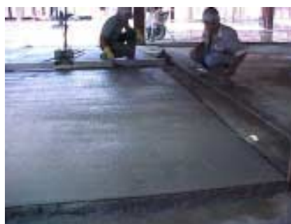
FIGURA 4.44 – Colocação e solidarização das lajes pré-moldadas e estrutura metálica
