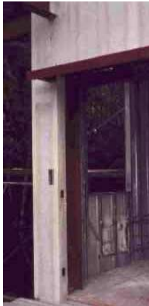
FIGURA 3.2 – Montagem do sistema de fechamento vertical em placas cimentíceas
