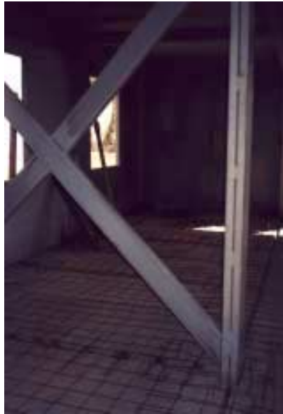
FIGURA 4.15 – Painéis de concreto pré-moldado para piso antes do capeamento
