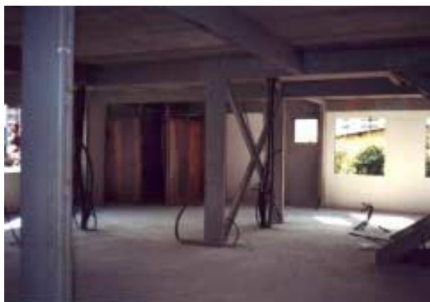
FIGURA 4.24 – Limpeza e mobilidade na obra
