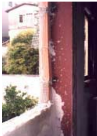
FIGURA 4.2 – Ligação alvenaria/estrutura com tela “ ancofix ”
