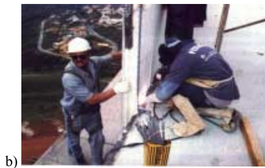
FIGURA 4.32 – Fixação dos painéis de vedação externos
