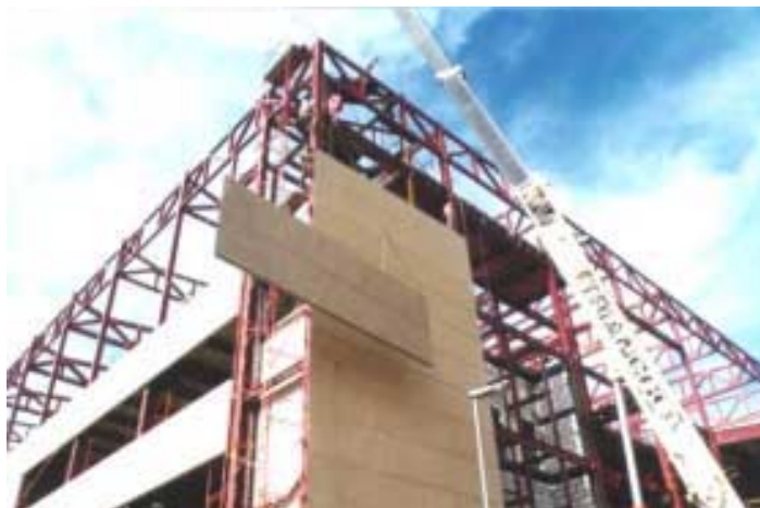
FIGURA 4.45 – Montagem dos painéis externos
