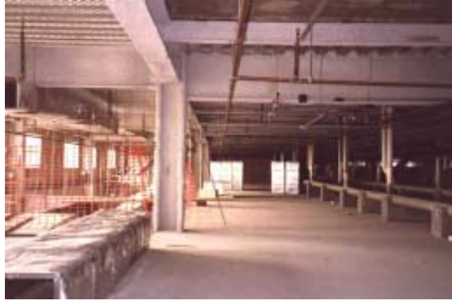
FIGURA 4.56 – Limpeza da obra
