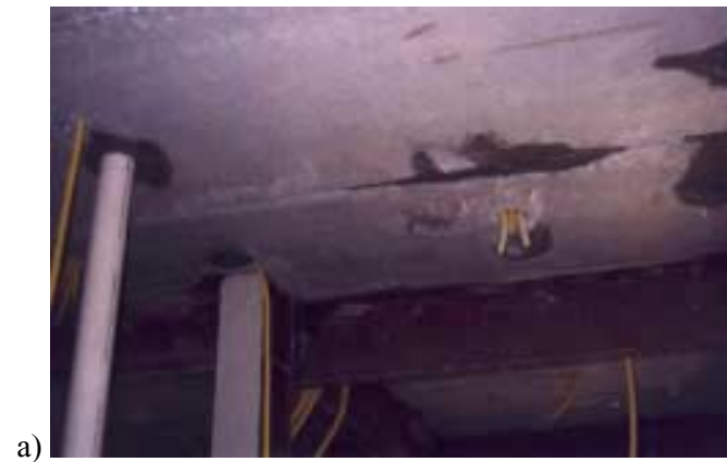
FIGURA 4.3 – Ligação alvenaria estrutura com cantoneira metálica
