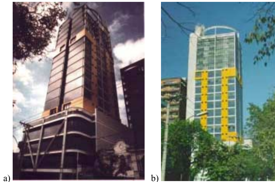
FIGURA 4.13 – Vistas do Edifício Scala Work Center
