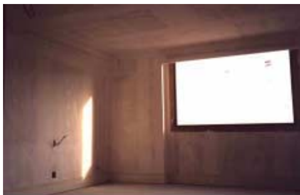
FIGURA 4.54 – Fechamento divisórias internas com placas de gesso acartonado
