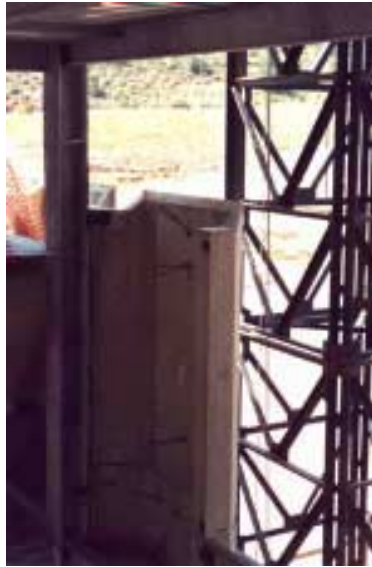
FIGURA 3.4 – PAINEL PRÉ-MOLDADO DE CONCRETO MACIÇO
