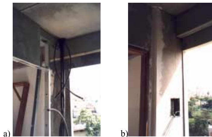
FIGURA 4.22 – Improviso na criação de “shafts”
