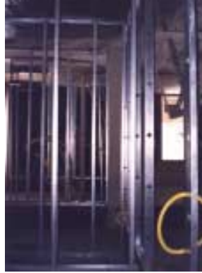
FIGURA 4.5 – Perfis metálicos para montagem das divisórias de gesso acartonado
