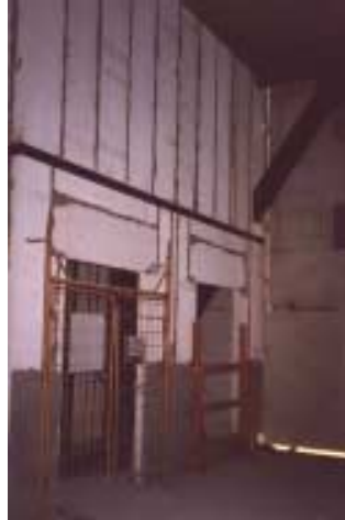
FIGURA 4.64 – Vedação interna em painéis de concreto celular autoclavado
