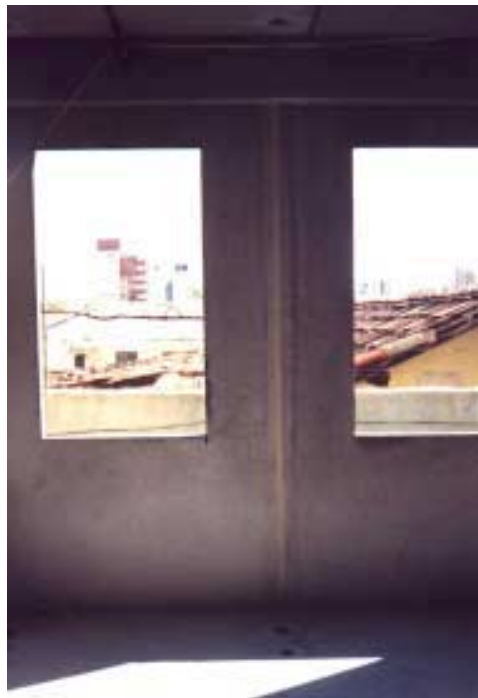
FIGURA 4.18 – Juntas entre painéis de fachada (internamente)
