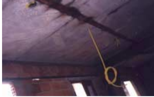
FIGURA 3.8 – Teto de edificação com estrutura metálica e lajes em painéis pré-moldados de concreto
