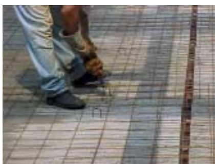
FIGURA 4.44 – Colocação e solidarização das lajes pré-moldadas e estrutura metálica
