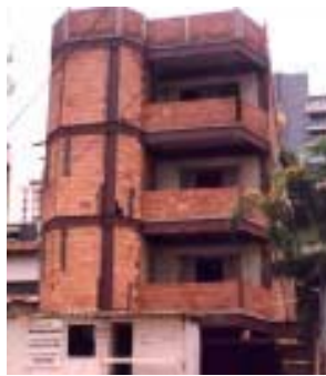
FIGURA 1.1 – Alvenaria e estrutura metálica em edifício residencial – BH - dez/1999
