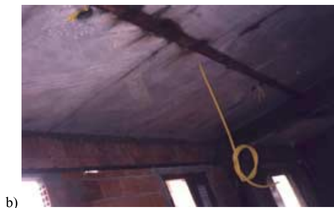
FIGURA 4.4 – Laje em painéis de concreto pré-moldado
