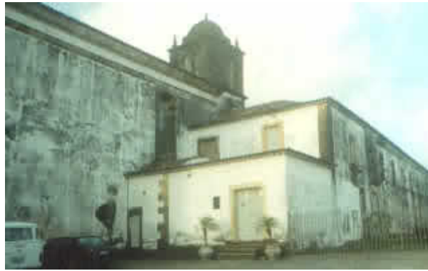
Figura 2 – Vista lateral do Seminário de Olinda
