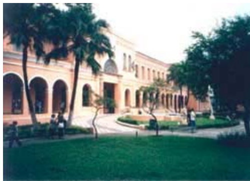
Figura 3: Fachada principal do Memorial do Imigrante.
