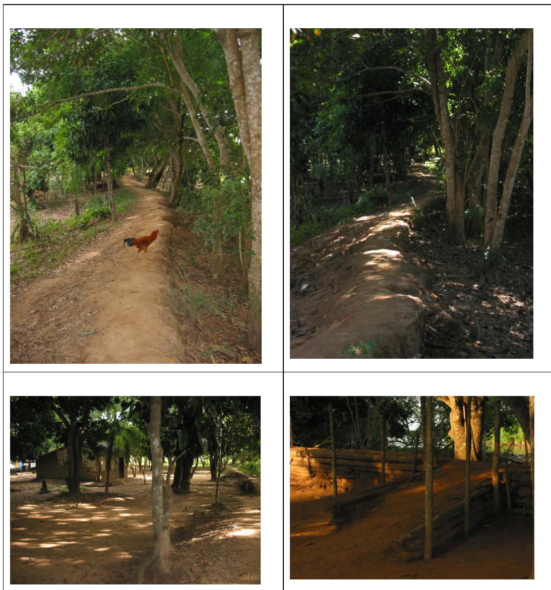
Figura 10: Açude construído na Comunidade Cuiabá Mirim, como adaptação as enchentes do rio Cuiabá.
