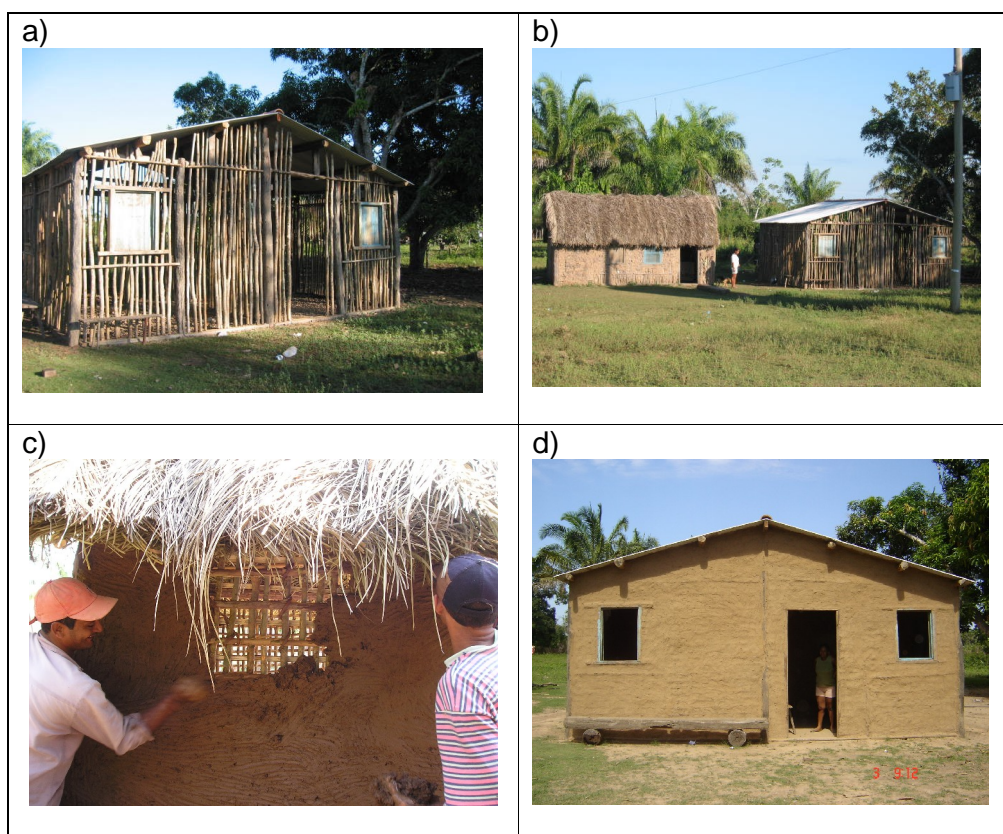
Figura 11: Fases da construção da casa de Pedrão. a) casa com esteios , cobertura e barrotes . b) casa atual ao lado da casa nova que está em construção. c) Casa sendo barreada . d) casa pronta.
